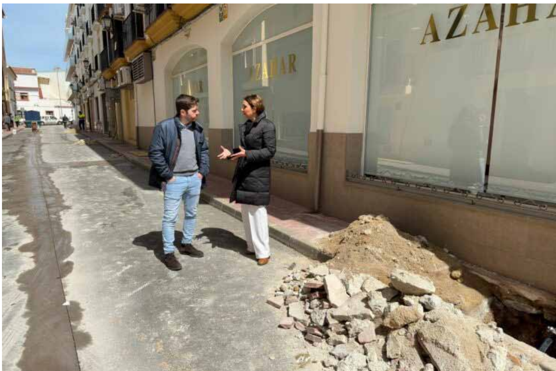
Los trabajos de mejora de las redes se han iniciado este martes.
