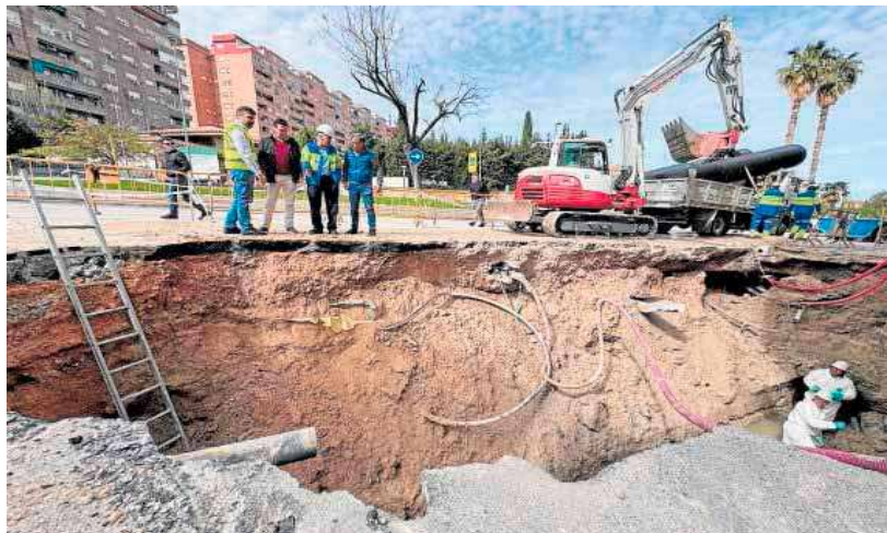
Trabajos de reparación ayer en el socavón generado en la avenida de Arjona. IDEAL
