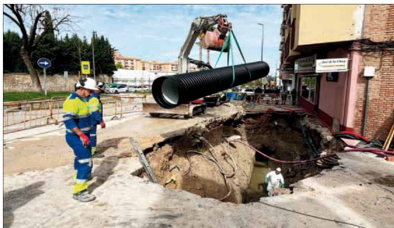
AVENIDA DE ARJONA. Los técnicos de Aqualia introducen el nuevo colector en el socavón causado por el temporal en la Avenida de Arjona de la capital jiennense.
