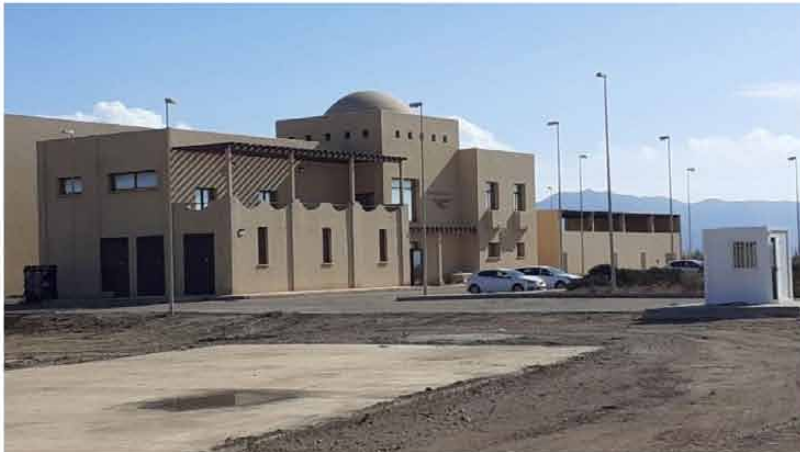
Instalaciones de la inédita desaladora Mar de Alborán. La Voz
