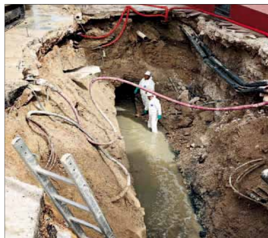
AVENIDA DE ARJONA. Los técnicos de Aqualia introducen el nuevo colector en el socavón causado por el temporal en la Avenida de Arjona de la capital jiennense.
